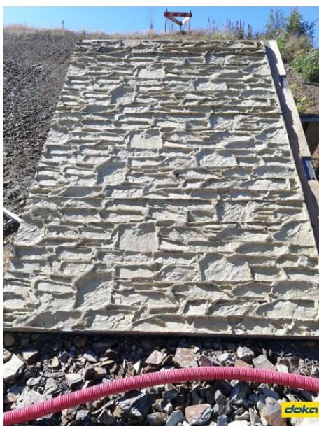
Matrice installée sur les banches Framax. Crédit photo : Doka
