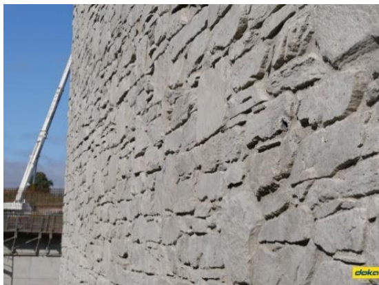
Une belle finition béton rendue possible grâce à Framax habillé d'une matrice. Crédit photo : Doka
