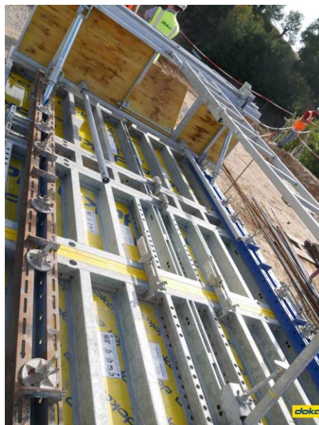
Dokaset, la banche toute équipée avec la sécurité déjà intégrée. Crédit photo : Doka
