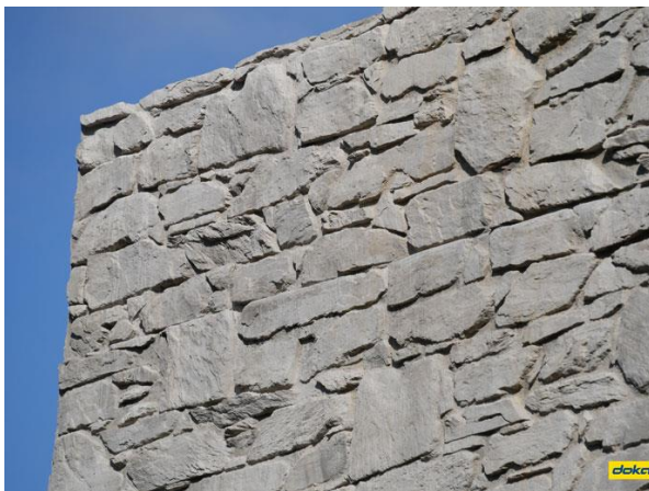
Béton matricé aspect parement pierre de Schiste. Crédit photo : Doka
