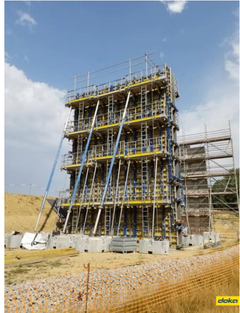
Voile réalisé en Framax jusqu'à 12 m de haut et 7 m de large. Crédit photo : Doka
